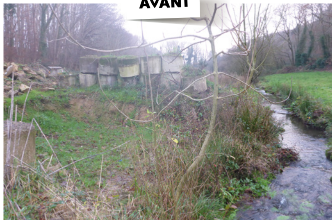
Rive gauche : avant les travaux
