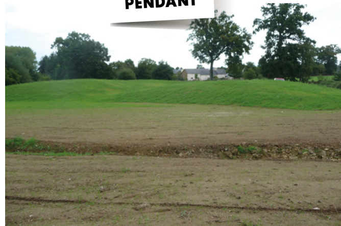
Travaux de terrassement et ensemencement
