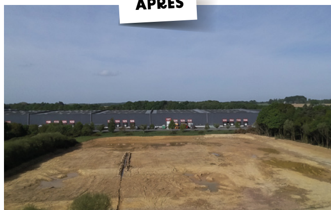
2020 - Après les travaux
