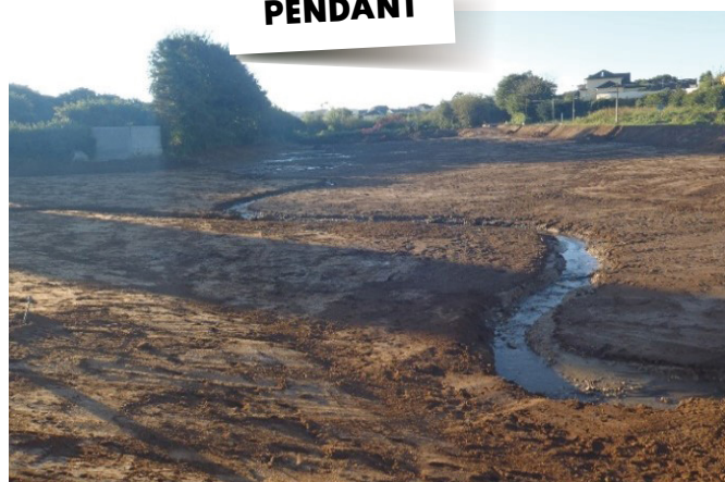
Fin des travaux de terrassement
