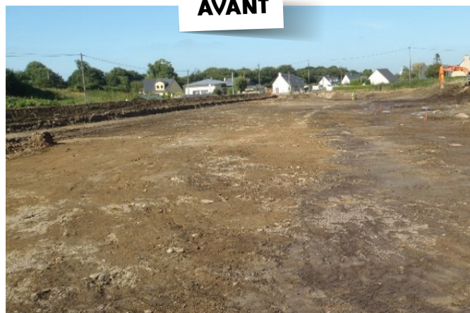
Début des travaux
