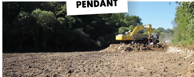
Extraction des remblais
